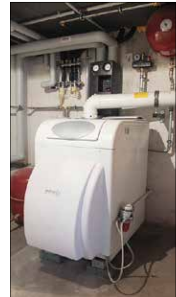
Sorgen für Wärme: Kaminofen, Kombi-Pufferspeicher und die Öl-Brennwert-Heizung. Fotos: IWO (l.) / Mertz (r.)
